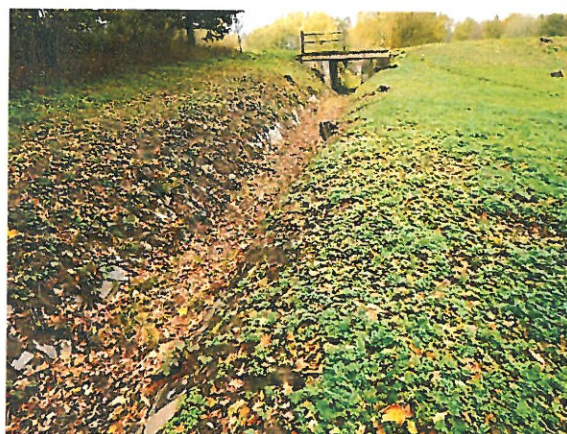
Pohled na zanesený odpad z BP
